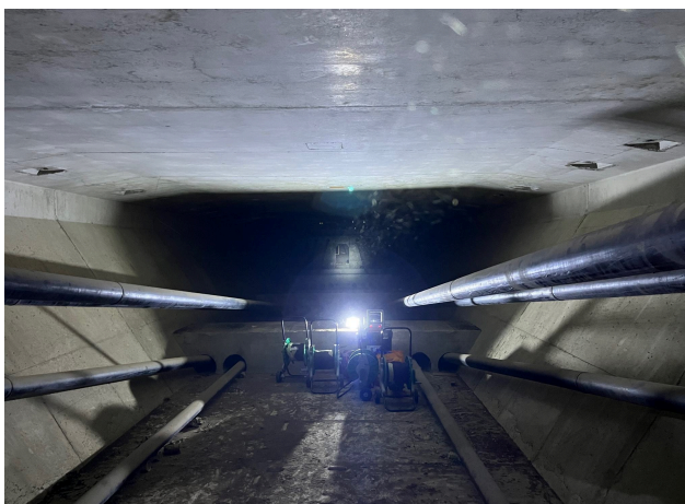
Figura 1. Interior de la viga sección cajón del viaducto de Tremor.
