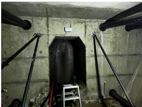
Figura 2. Disposición de los puntales en el viaducto.
